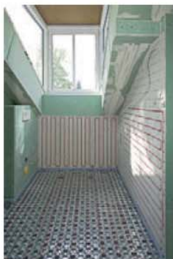
Bild 2.20: Wand- und FB-Heizung im Bad DG [15]
